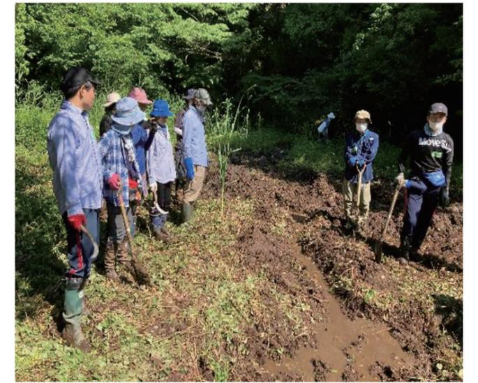
図2:千葉県富里市の谷津における湿地再生の様子(2024年5月25日)。写真のような土水路を湧水湧出箇所から下流域まで整備し、再生湿地の用水として利用する。
