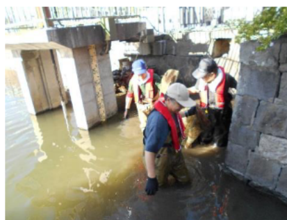
▲川の中の石倉カゴを引き上げる作業
